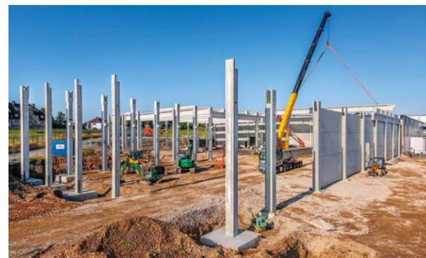
Die Errichtung der Stahlkonstruktion für die Halle und die Außenwände erfolgte mit einem Autokran.
