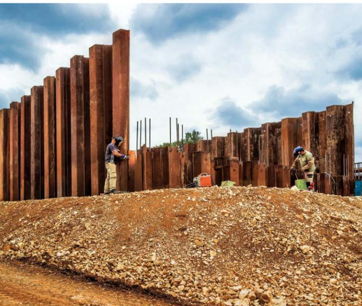
6 m hohe Spundwände dienen als Auflager für die Behelfsbrücke.
